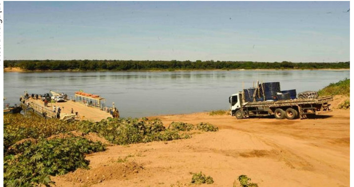
Lugar da construção da ponte.
